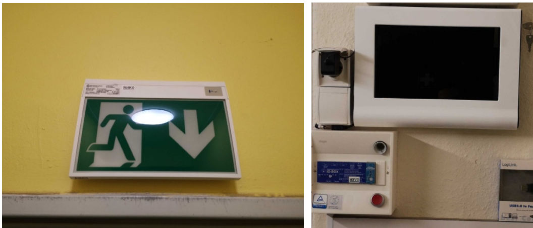
Abbildung: Einzelbatterie-Rettungszeichenleuchte (links) und Funkgeschütztes System (rechts)
